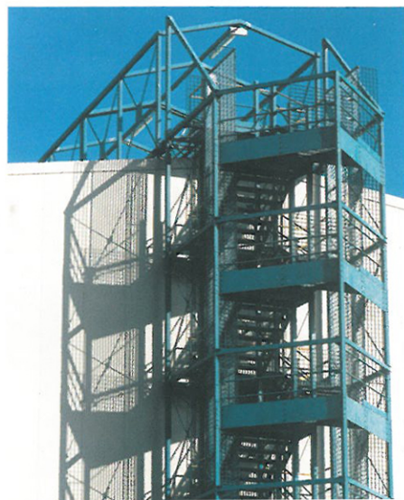
Particolare della scala che conduce al percorso di servizio posto sulla copertura
