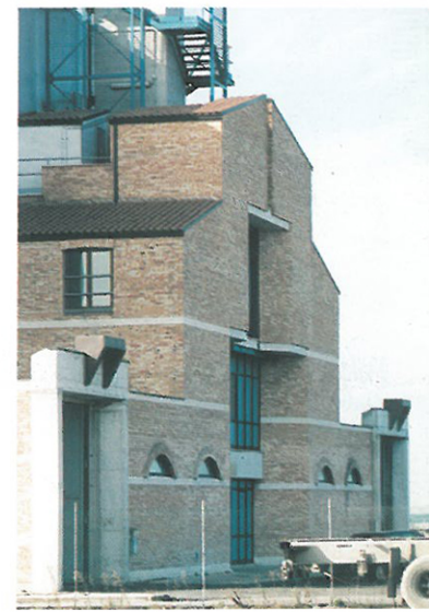
5 Particolare del corpo di accesso
