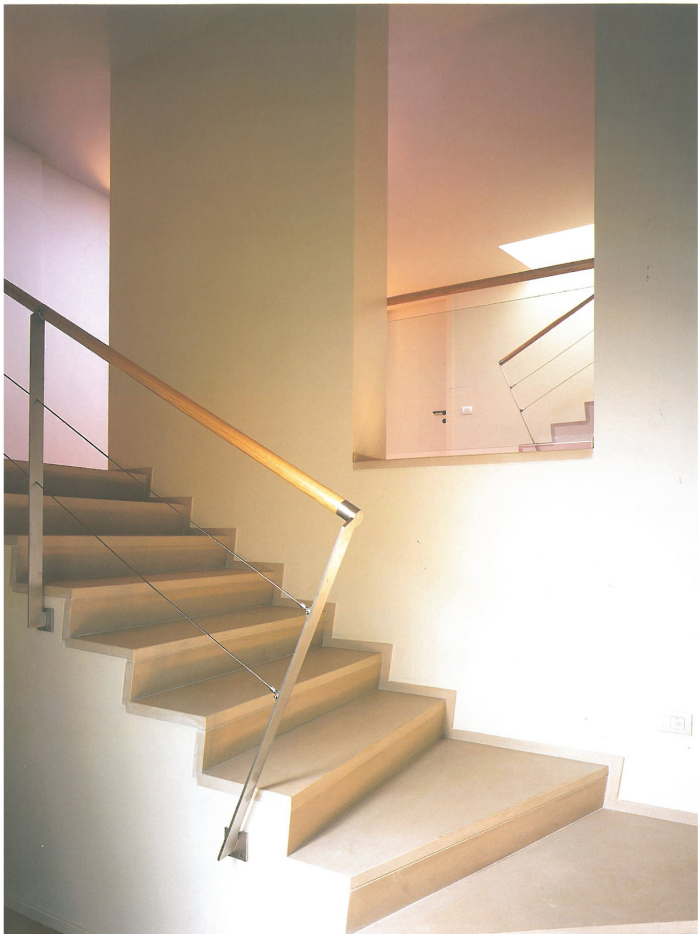
Scala di raccordo tra i piani, in pietra aesina, con balastra in acciaio e legno
